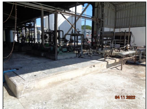
รูปที่ 2-13 ระบบปรับสภาพความเป็นกรด-ด่าง (Neutralization Pit)
