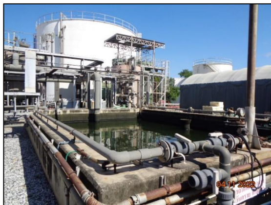
รูปที่ 2-11 การนำน้ำที่ผ่านการบำบัดแล้วมาใช้ใหม่ ระบบ Recovery basin
