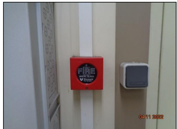
ปุ่มกดสัญญาณเตือนไฟไหม้
